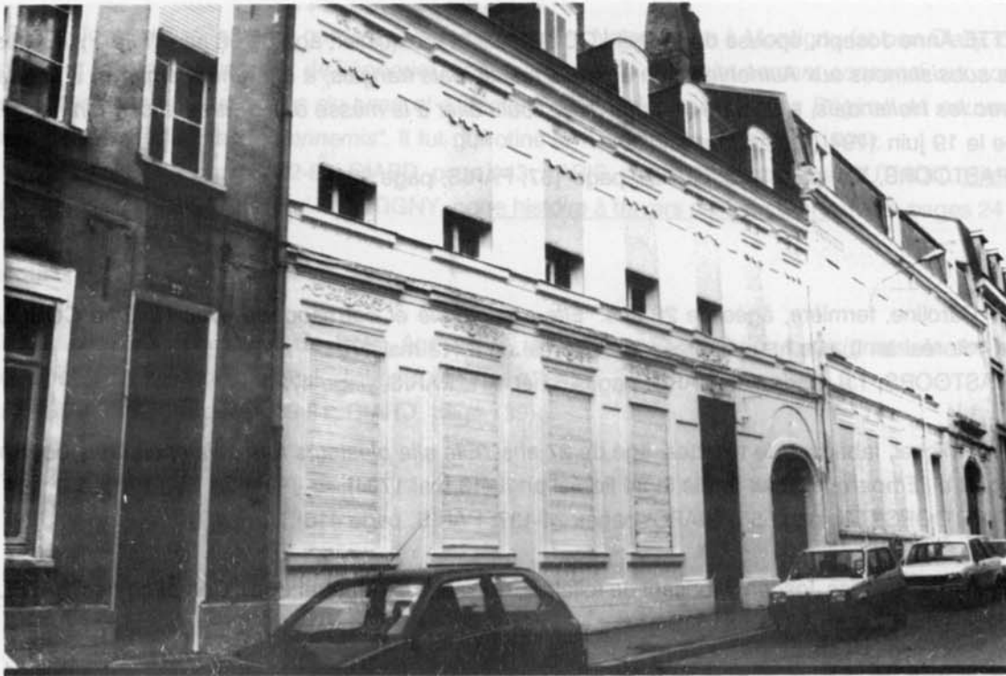
Résidence de Joseph LEBON à Cambrai (ancien hôtel PARIGOT de SENTENAY, 35 rue Saint-Géry). C'est aujourd'hui l'étude de Maître LEPOIVRE, notaire à Cambrai, au 16-18 rue Saint-Géry
