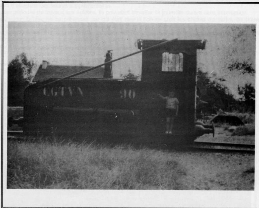
*Sur cette photographie d'une machine stationnée à Banteux, on distingue la perche qui servait à mettre le trolley sur le fil électrique, le crochet (à proximité de la cabine) qui servait à introduire le câble, les protège-roues, les tampons et la bâche à tringles qui permettait au machiniste de se protéger de la pluie...*
